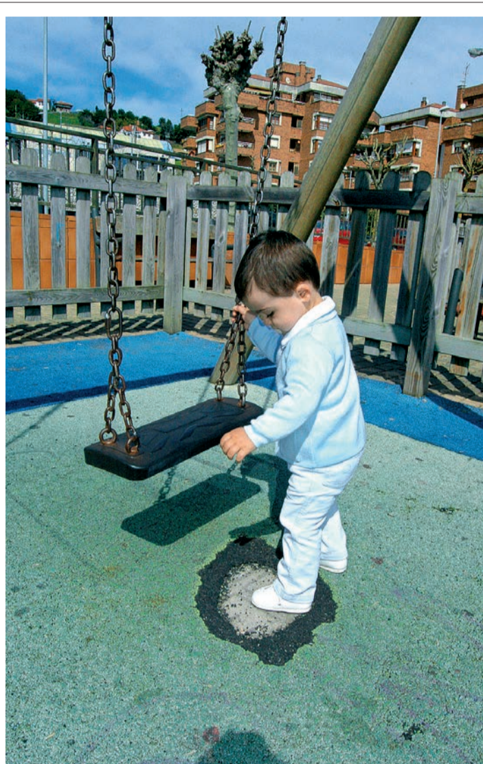
Un pequeño, a punto de tropezar con un socavón. (P. F.)
