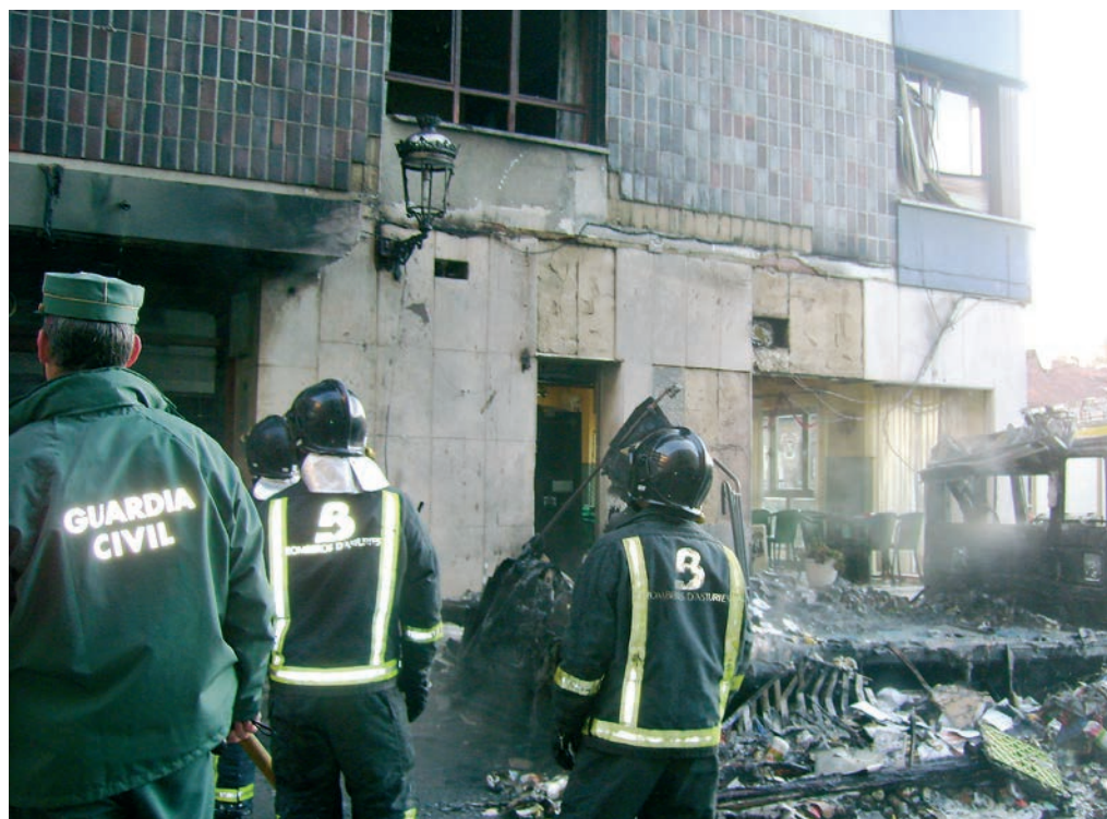
Los bomberos y la Guardia Civil, durante las labores de extinción del incendio. (L. V.)
